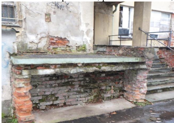
Foto č. 57-60– přístavba, poškození omítek, děrovaného zdiva, hlavy komína
