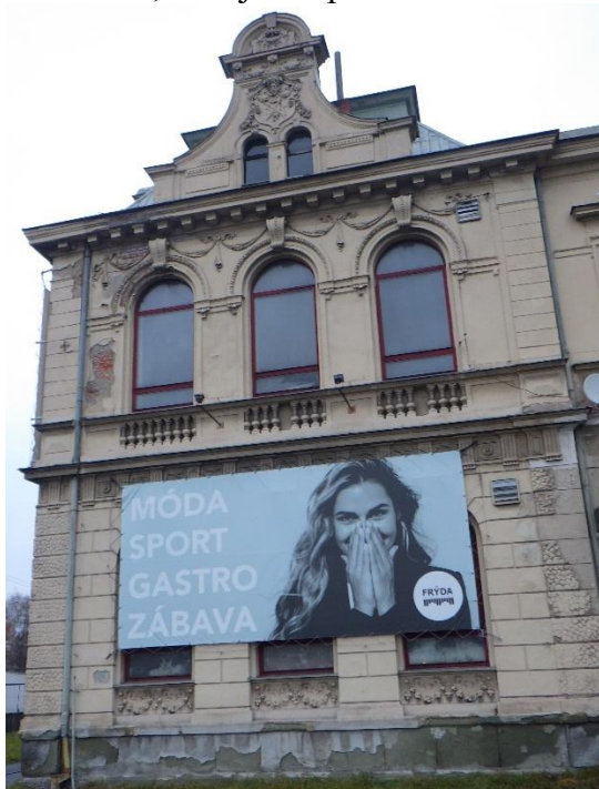
Foto č. 33-35 – poškození omítek římsy a pod římsou na jižním nároží, detail trhliny mezi římsou a „kvádrem“ pod římsou
