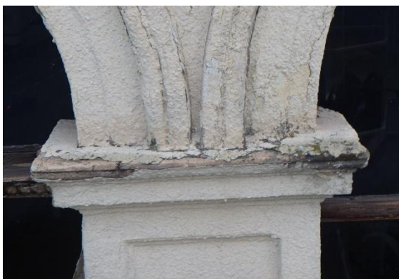
Foto č. 42-43 – trhliny na šambráně okna
