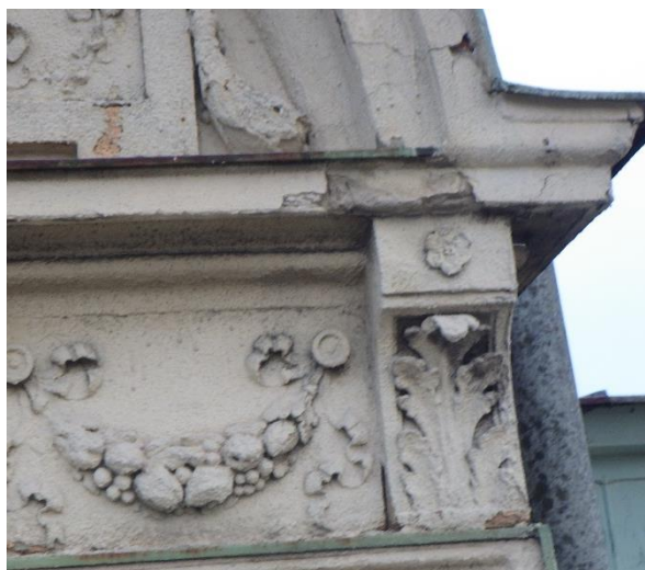
Foto č. 42-43 – trhliny na šambráně okna
