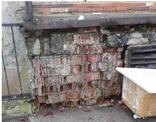
Foto č. 57-60– přístavba, poškození omítek, děrovaného zdiva, hlavy komína
