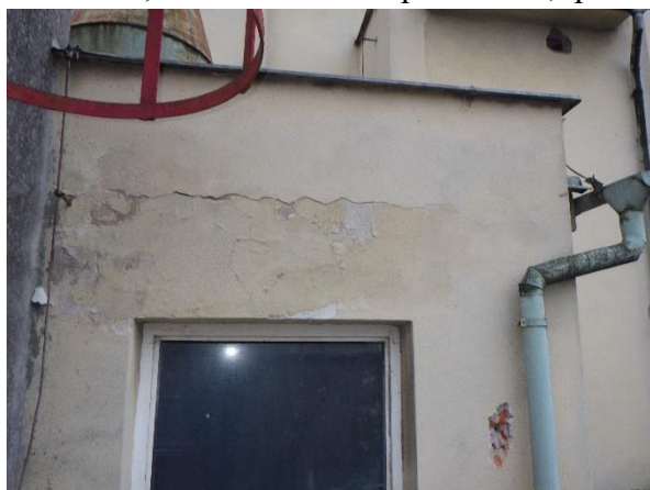
Foto č. 63, 64– trhlina v nadpraží okna, poškození omítky
