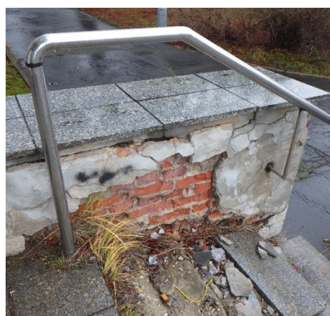
Foto č. 69- 71 – stříška nad schodištěm na JZ fasádě – koroze ocel. nosníku, poškození desek hruďis, rozpad čel a několika desek, hrozí zborcení části konstrukce
