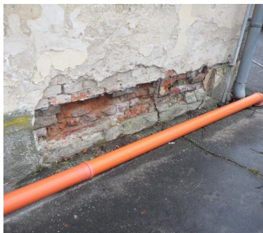
Foto č. 56 – východní strana objektu – přístavba, poškození omítek a děrovaného zdiva
