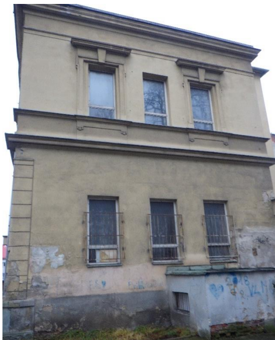
Foto č. 54, 55 – severovýchodní fasáda – pohled na historickou část, poškozený sokl
