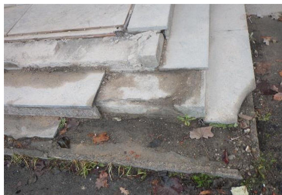
Foto č. 29-30 – poškození zdiva soklu do hloubky, trhliny v parapetním zdivu
