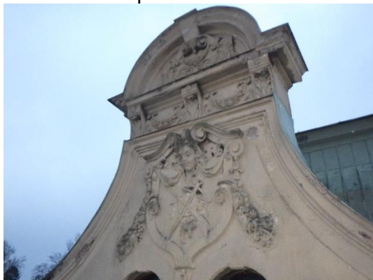
Foto č. 3 - 8 – poškození omítek na vrcholovém štítu
