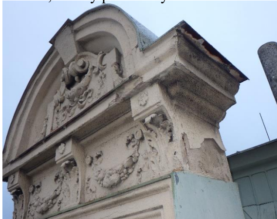
Foto č. 36-41 – poškození omítek na vrcholovém štítu, detaily poškozených ozdob
