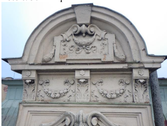
Foto č. 36-41 – poškození omítek na vrcholovém štítu, detaily poškozených ozdob
