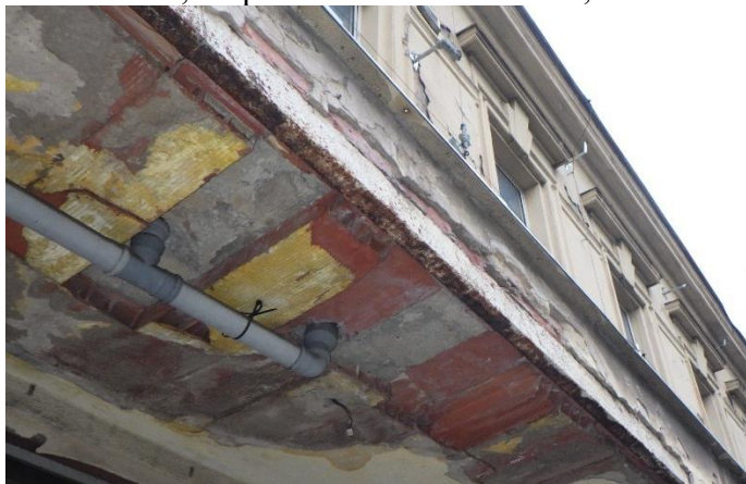
Foto č. 69- 71 – stříška nad schodištěm na JZ fasádě – koroze ocel. nosníku, poškození desek hruďis, rozpad čel a několika desek, hrozí zborcení části konstrukce
