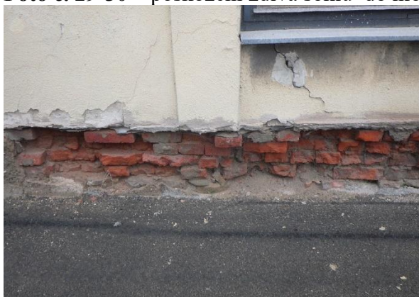
Foto č. 29-30 – poškození zdiva soklu do hloubky, trhliny v parapetním zdivu
