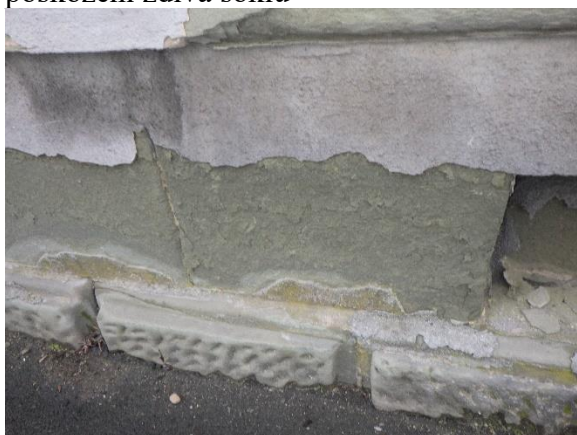
Foto č. 29-30 – poškození zdiva soklu do hloubky, trhliny v parapetním zdivu
