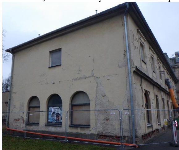
Foto č. 56 – východní strana objektu – přístavba, poškození omítek a děrovaného zdiva
