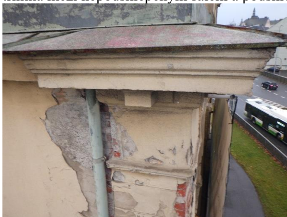
Foto č. 16-22 – poškození omítek, trhlinky, chybějící části výzdoby, poškození zdiva, svislá trhлина mezi nepodsklepeným sálem a podsklepenou částí budovy
