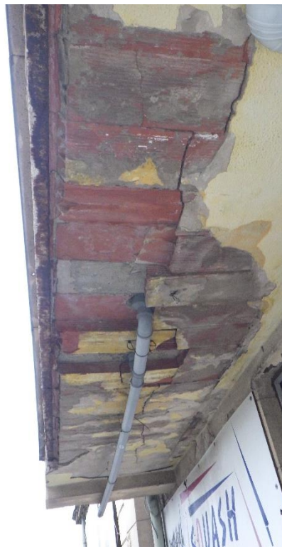
Foto č. 69- 71 – stříška nad schodištěm na JZ fasádě – koroze ocel. nosníku, poškození desek hruďis, rozpad čel a několika desek, hrozí zborcení části konstrukce
