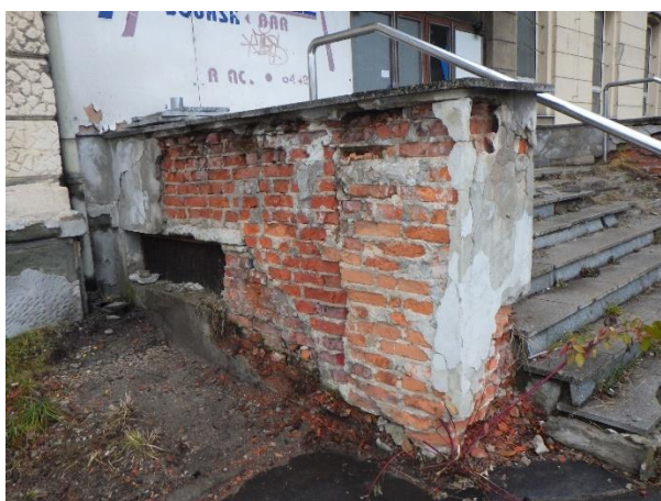
Foto č. 69- 71 – stříška nad schodištěm na JZ fasádě – koroze ocel. nosníku, poškození desek hruďis, rozpad čel a několika desek, hrozí zborcení části konstrukce
