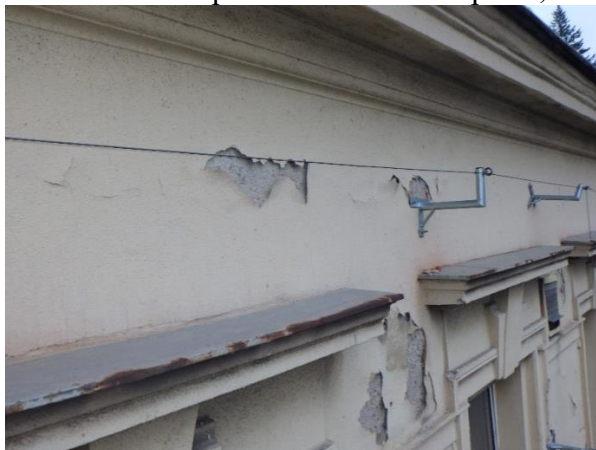
Foto č. 44-49 – poškození omítek v ploše, svislé trhliny na šambránách okolo oken,
