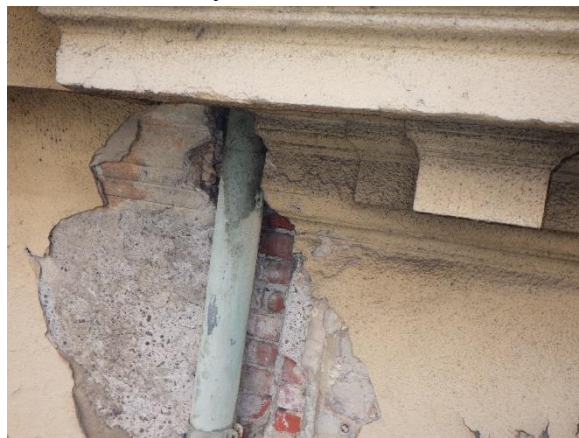
Foto č. 16-22 – poškození omítek, trhlinky, chybějící části výzdoby, poškození zdiva, svislá trhлина mezi nepodsklepeným sálem a podsklepenou částí budovy
