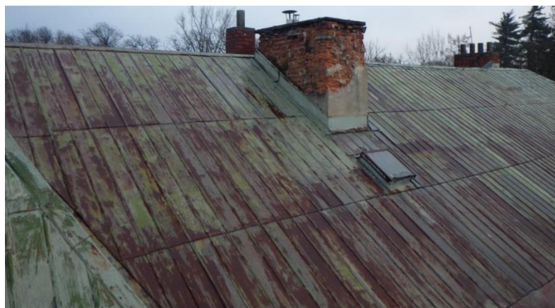
Foto č. 50-51 – stav komínu – poškozené omítky a vydrolování zdiva , plošná koroze krytiny
