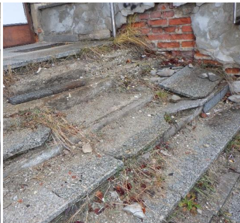
Foto č. 65- 68 – schodiště na JZ fasádě – poškození stupňů, rozpad betonu, poškození zdiva zídce okolo schodiště
