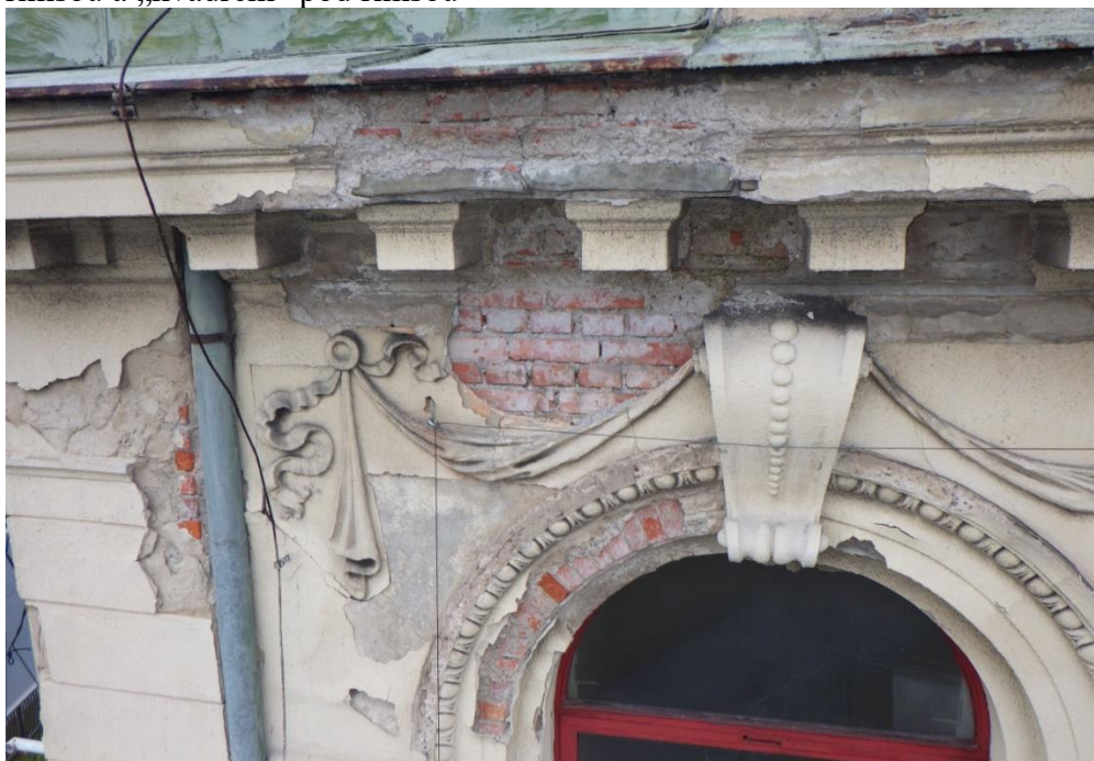
Foto č. 33-35 – poškození omítek římsy a pod římsou na jižním nároží, detail trhliny mezi římsou a „kvádrem“ pod římsou
