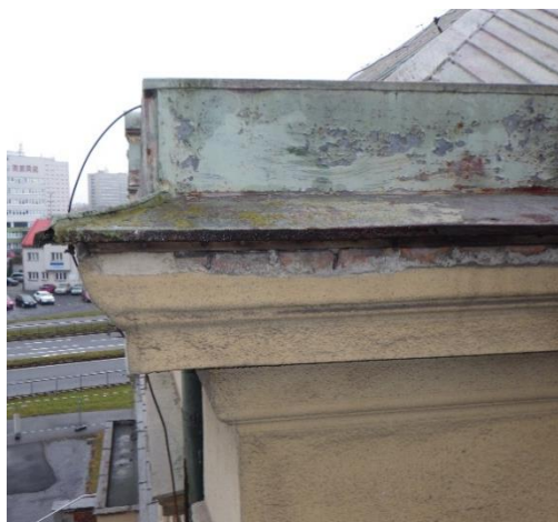
Foto č. 53 – poškození omítky pod oplechováním atiky
