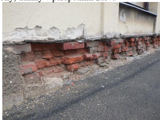
Foto č. 29-30 – poškození zdiva soklu do hloubky, trhliny v parapetním zdivu
