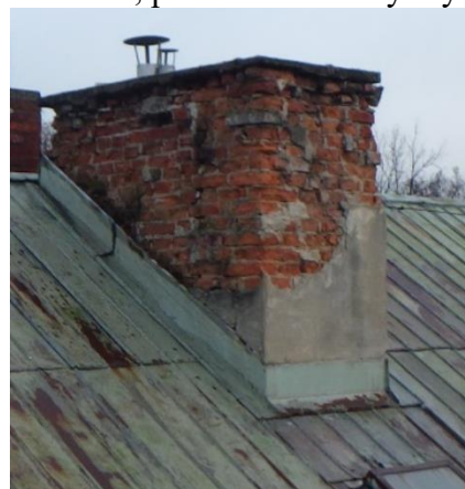
Foto č. 50-51 – stav komínu – poškozené omítky a vydrolování zdiva , plošná koroze krytiny
