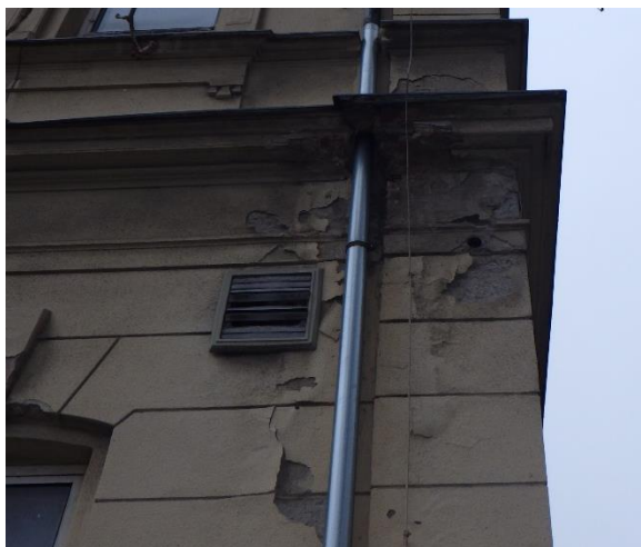
Foto č. 50-51 – stav komínu – poškozené omítky a vydrolování zdiva , plošná koroze krytiny
