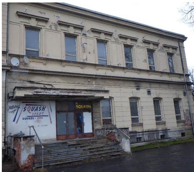
Foto č. 33-35 – poškození omítek římsy a pod římsou na jižním nároží, detail trhliny mezi římsou a „kvádrem“ pod římsou
