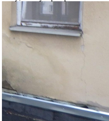
Foto č. 61, 62– zatékání do objektu nad střechou přístavby, trhliny v parapetu oken
