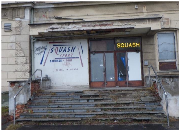
Foto č. 65- 68 – schodiště na JZ fasádě – poškození stupňů, rozpad betonu, poškození zdiva zídce okolo schodiště
