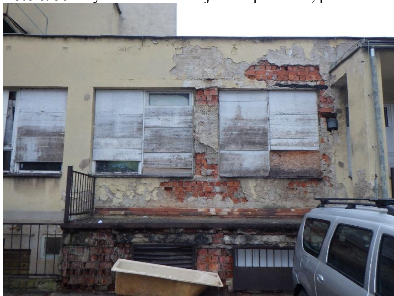
Foto č. 56 – východní strana objektu – přístavba, poškození omítek a děrovaného zdiva
