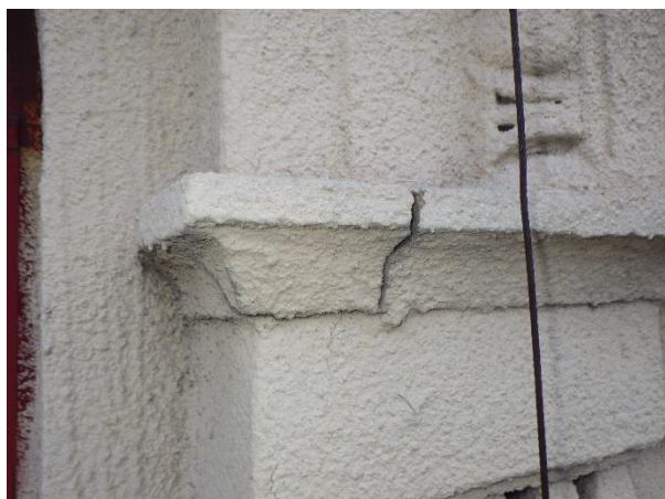
Foto č. 42-43 – trhliny na šambráně okna
