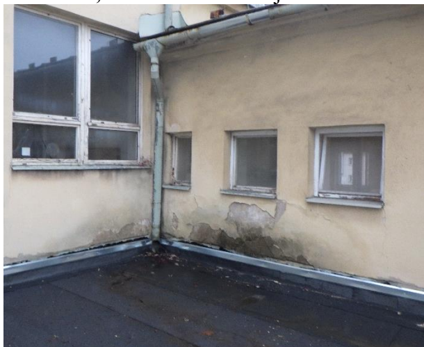
Foto č. 63, 64– trhlina v nadpraží okna, poškození omítky
